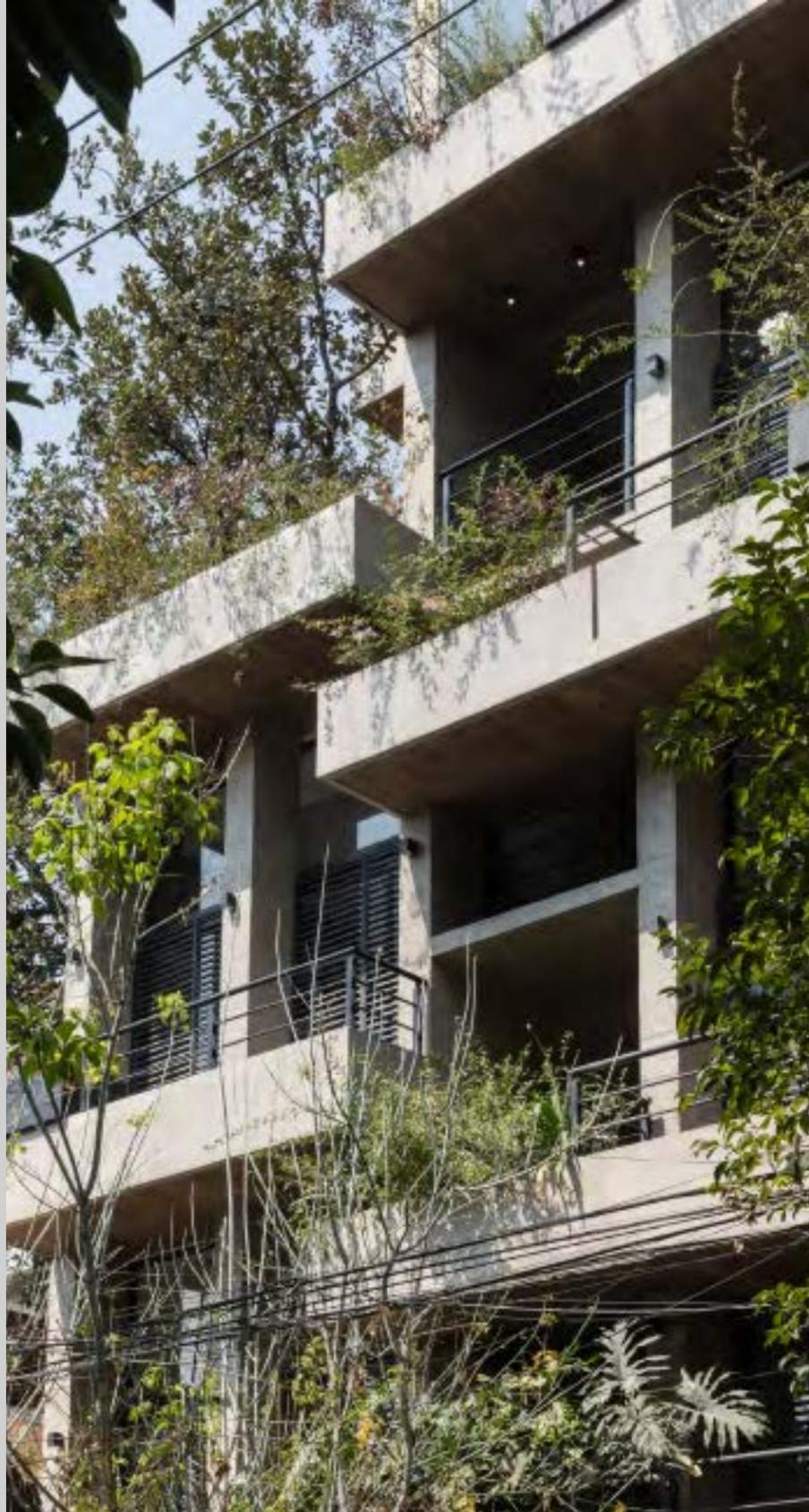
La estructura de concreto funciona bajo la lógica de muros de carga por lo que el edificio no tiene columnas ni travesaños, esto permite espacios limpios sin mochetas ni recovecos y nos ha permitido utilizar el concreto aparente como un acabado interior de los departamentos.
